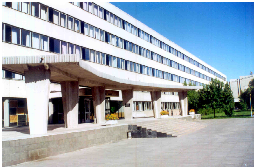
Главный корпус ГГМУ (2003 г.)
